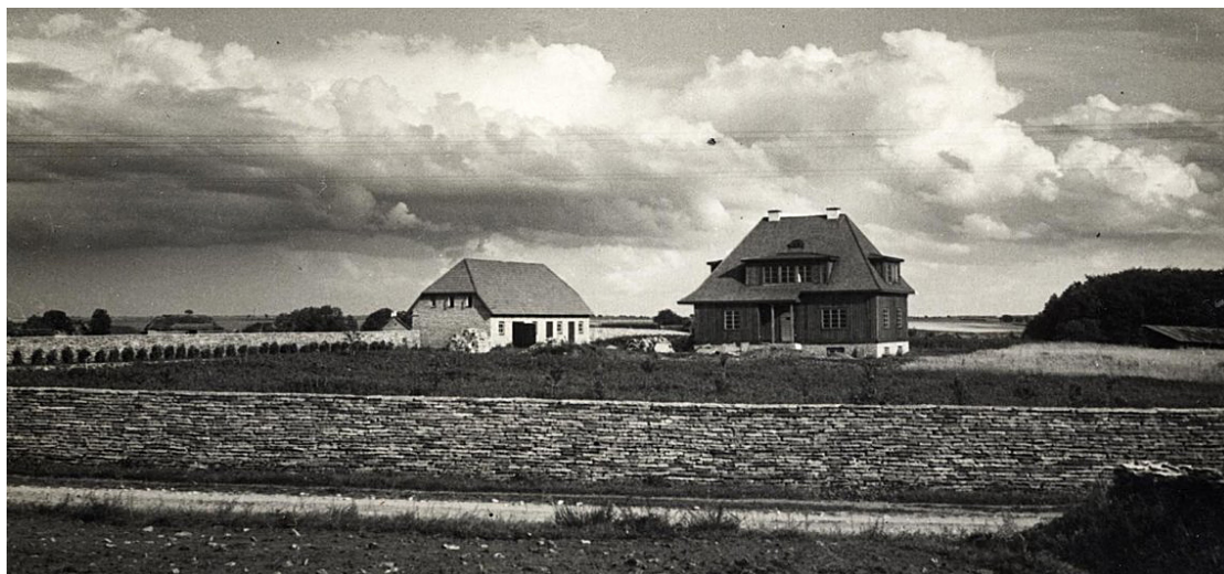
1931. aastal valminud August Volbergi projekteeritud Aedla taluhäärber Muuksis. Ehitus paistab lisaks kaunile üldmuljele ka kohaliku ehitusmaterjali – õhukesekihilise paekivi väga oskuslikult kasutamise poolest. Foto: Erika Volberg-Nõva.
